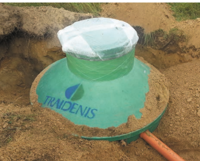
Przydomowa oczyszczalnia ścieków produkcji Traidenis-Pol
